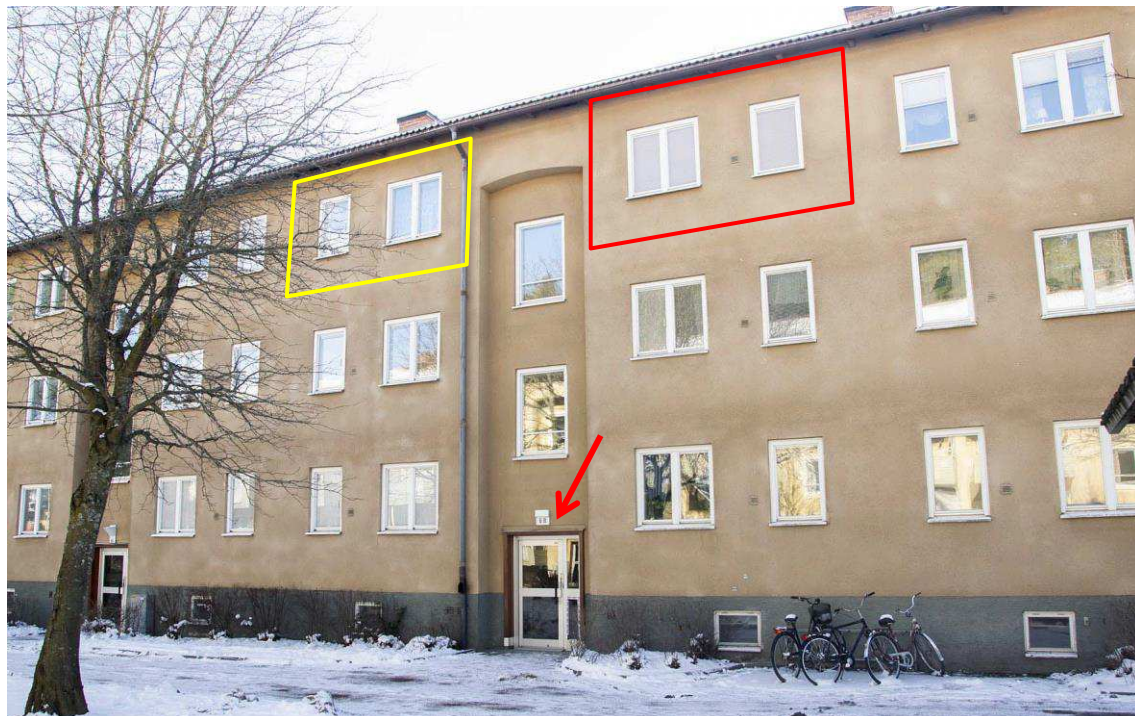
Bild 1. Fastighetens framsida med entrén till aktuellt trapphus.
