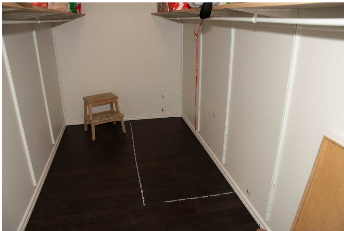
Figur 1. Förrådet innanför tvättstugan.
