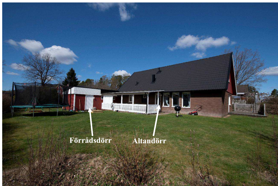
Figur 6. Humlegatan 14 fotograferat mot båda altanerna. Den vita dörren till vänster i bild leder in till förrådet och garaget. Under altantaket skymtar altandörren in mot vardagsrummet.
