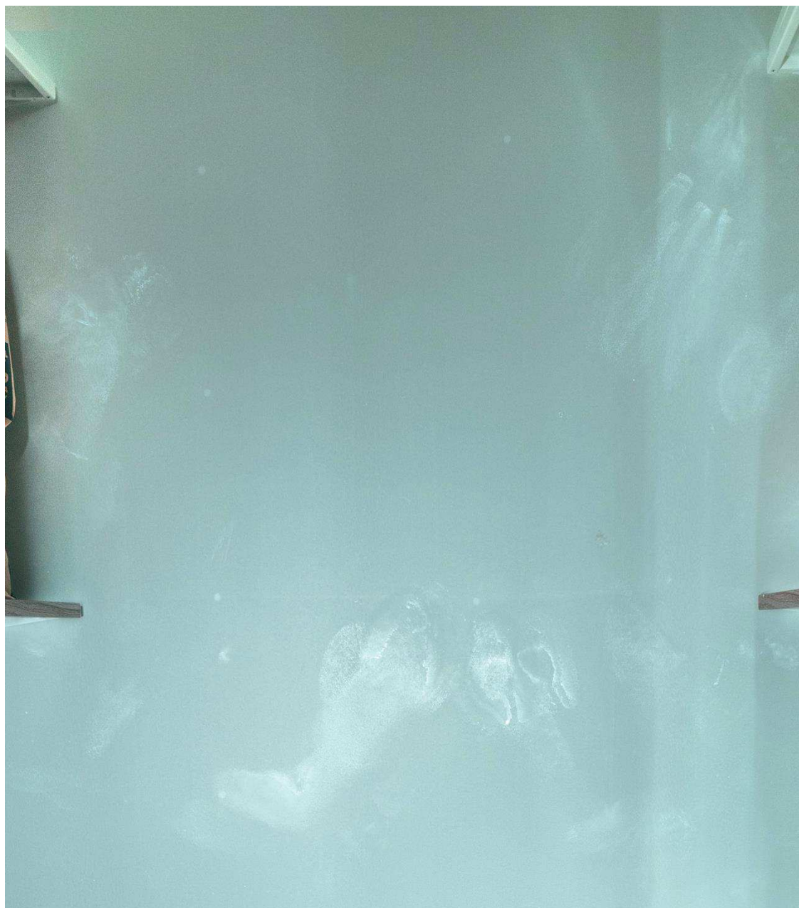
Figur 3. Delförstoring av figur 2 visande avtrycken på väggen.
