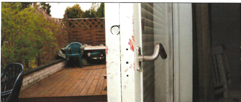
Figur 23. Öppningssidan/kortsidan av dörrbladet på altandörren.
