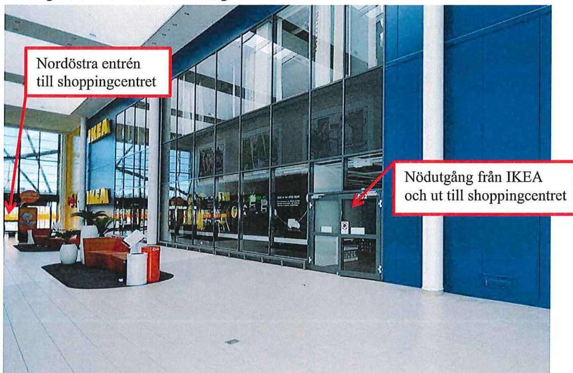
Figur 2. Översikt över nödutgången från IKEA's husgerådsavdelning och ut till shoppingcentret. Nödutgången består av två glasdörrar där de övre rutorna är av frostat glas och de undre rutorna av genomskinligt glas. Längst till vänster i bild skymtar delar av den nordöstra entrén till shoppingcentret.
