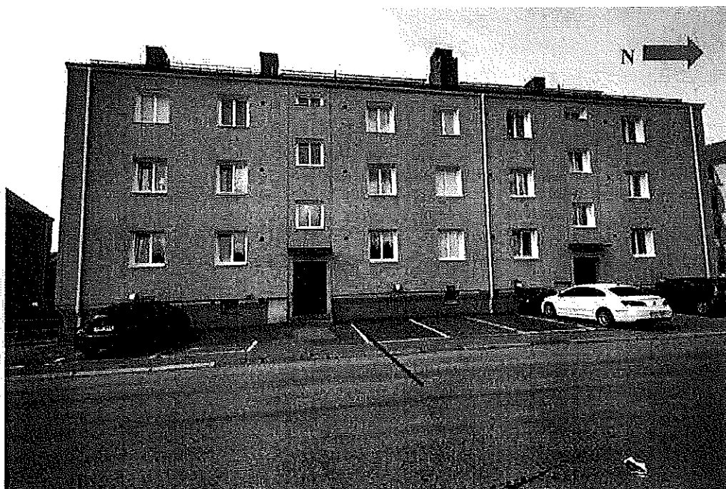
Bild 1. Framsidan av fastigheten på Sjövägen 4. Porten 4B är markerad med en pil.
