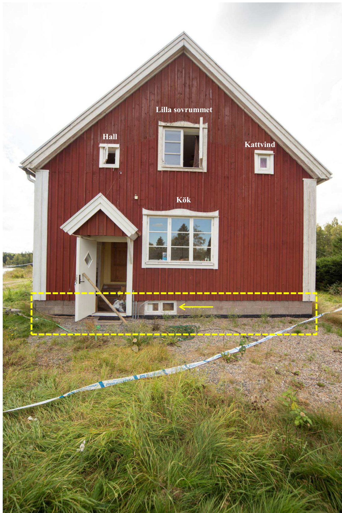
Figur 2. Torpets norra gavel. Gul rektangel markerar källaren. Gul pil pekar mot det från insidan övertäckta källarfönstret. På bilden har fönster på övervåningen och källardörren ställts upp av kriminaltekniker.
