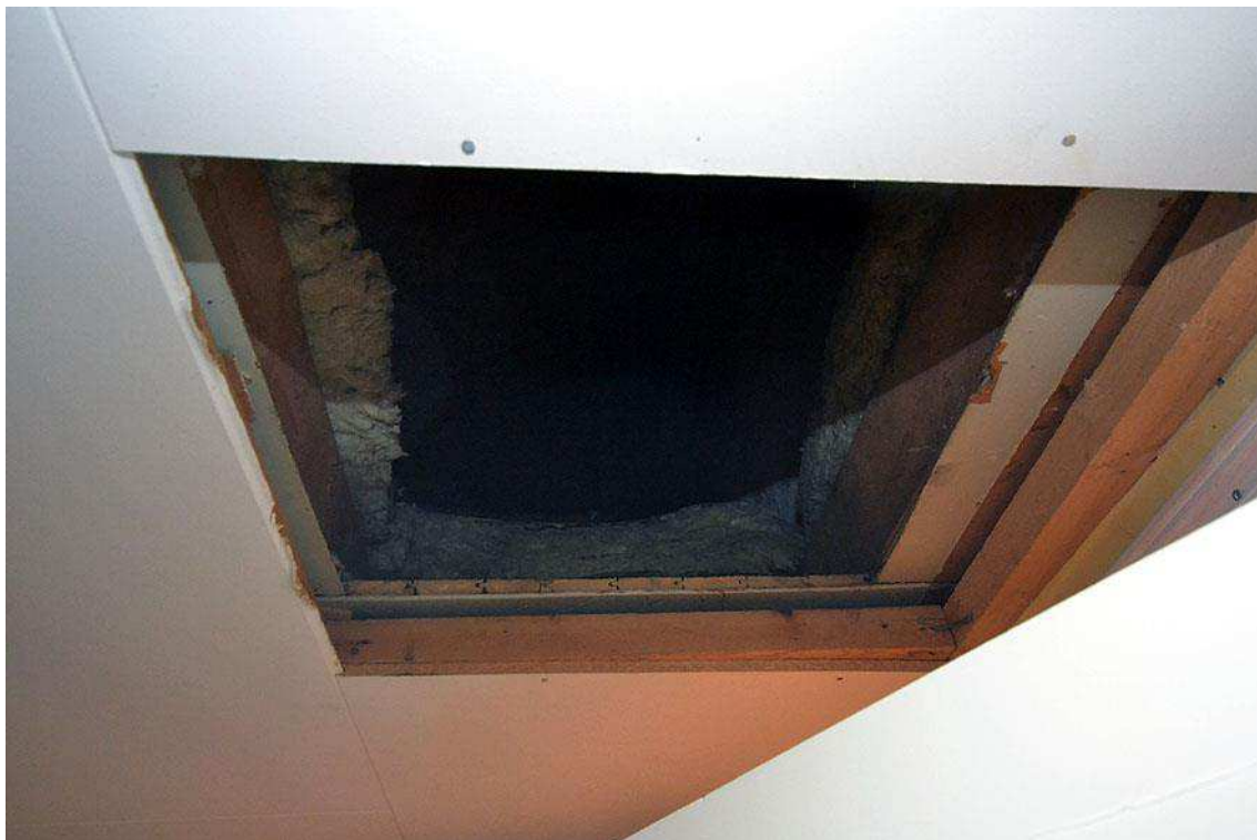
Figur 51. Vindslucka i i taket i hallen på övervåningen.
