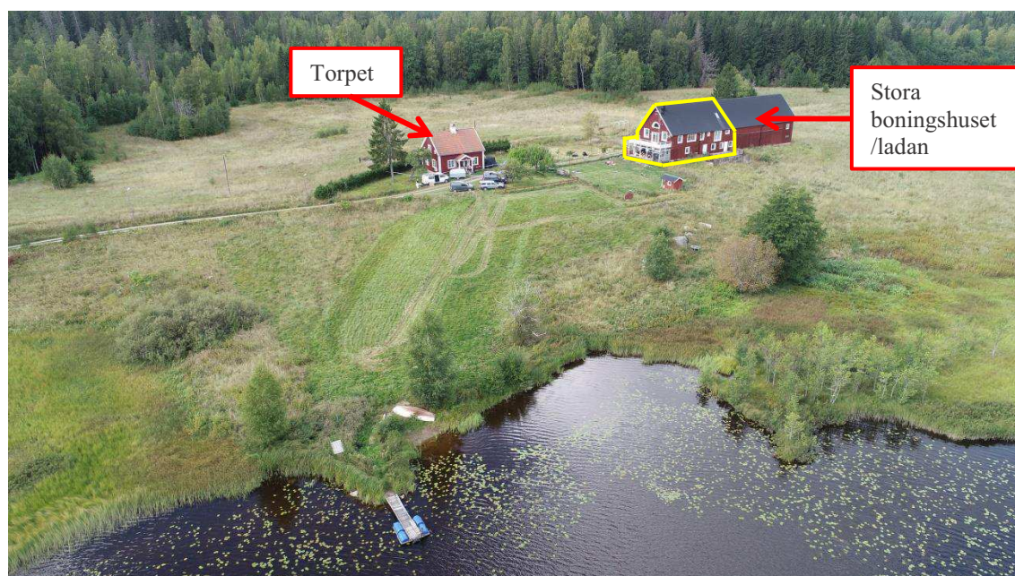
Figur 4. Del av fastigheten fotograferad med UAS i västlig riktning. Stora boningshuset har markerats i gult.
