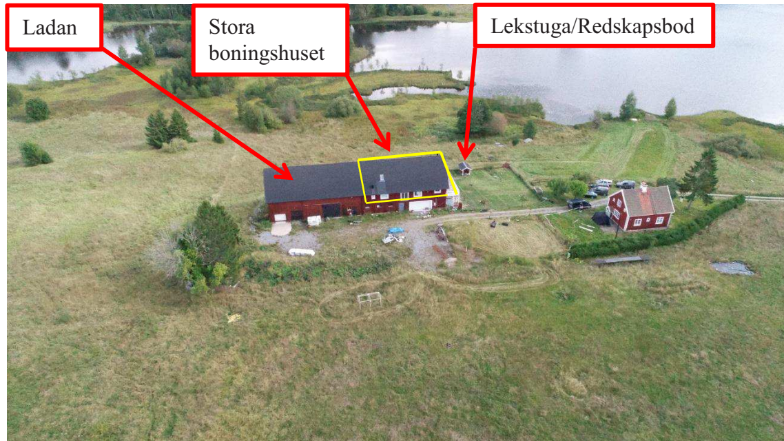
Figur 1. UAS 1 foto över gården Uttersberg 100. Byggnaderna är markerade med de benämningar som används i protokollet
