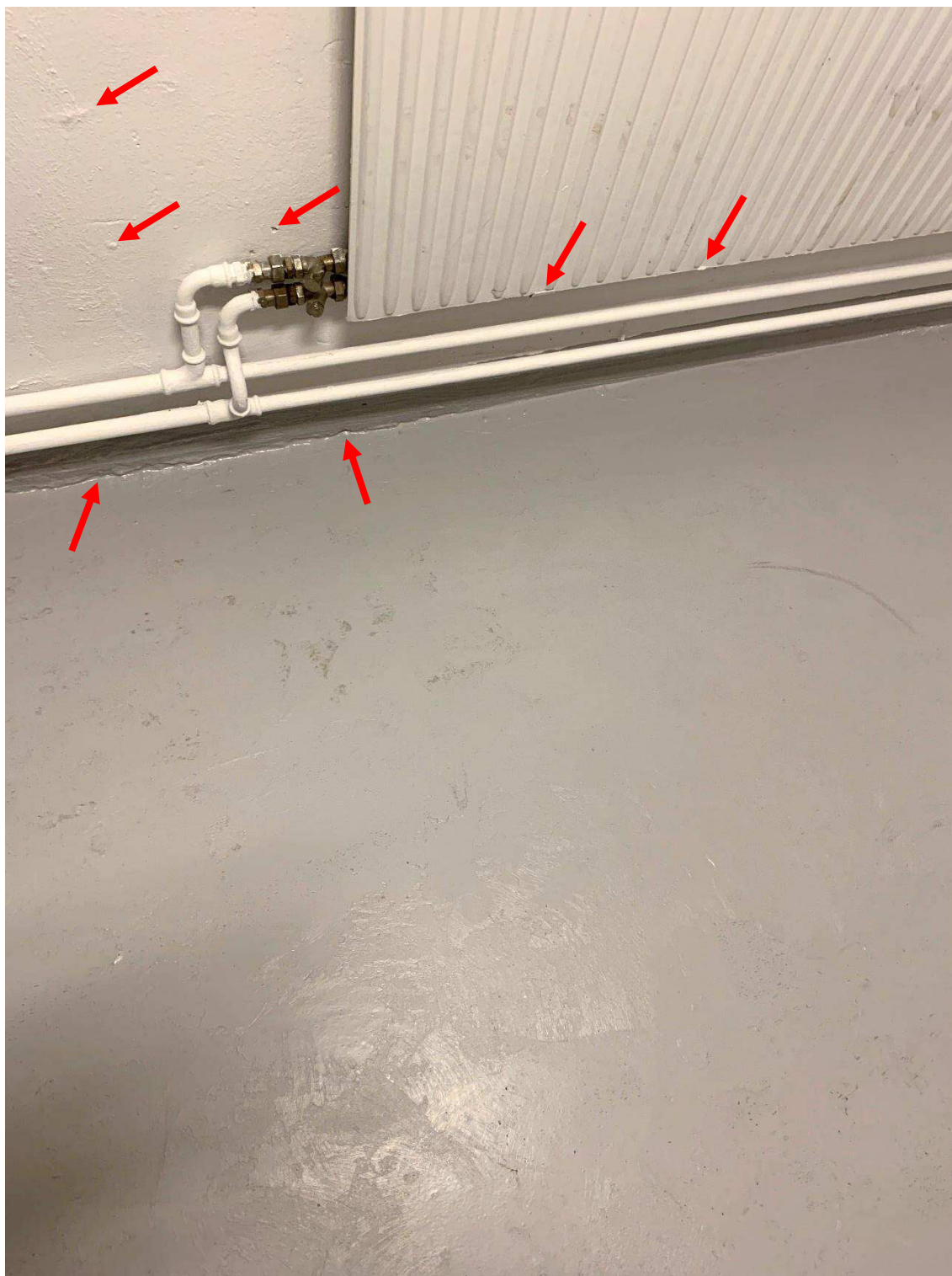
Figur 4. Närbild på området i förrådkorridoren på Puddelugnsgratan 27-31.
