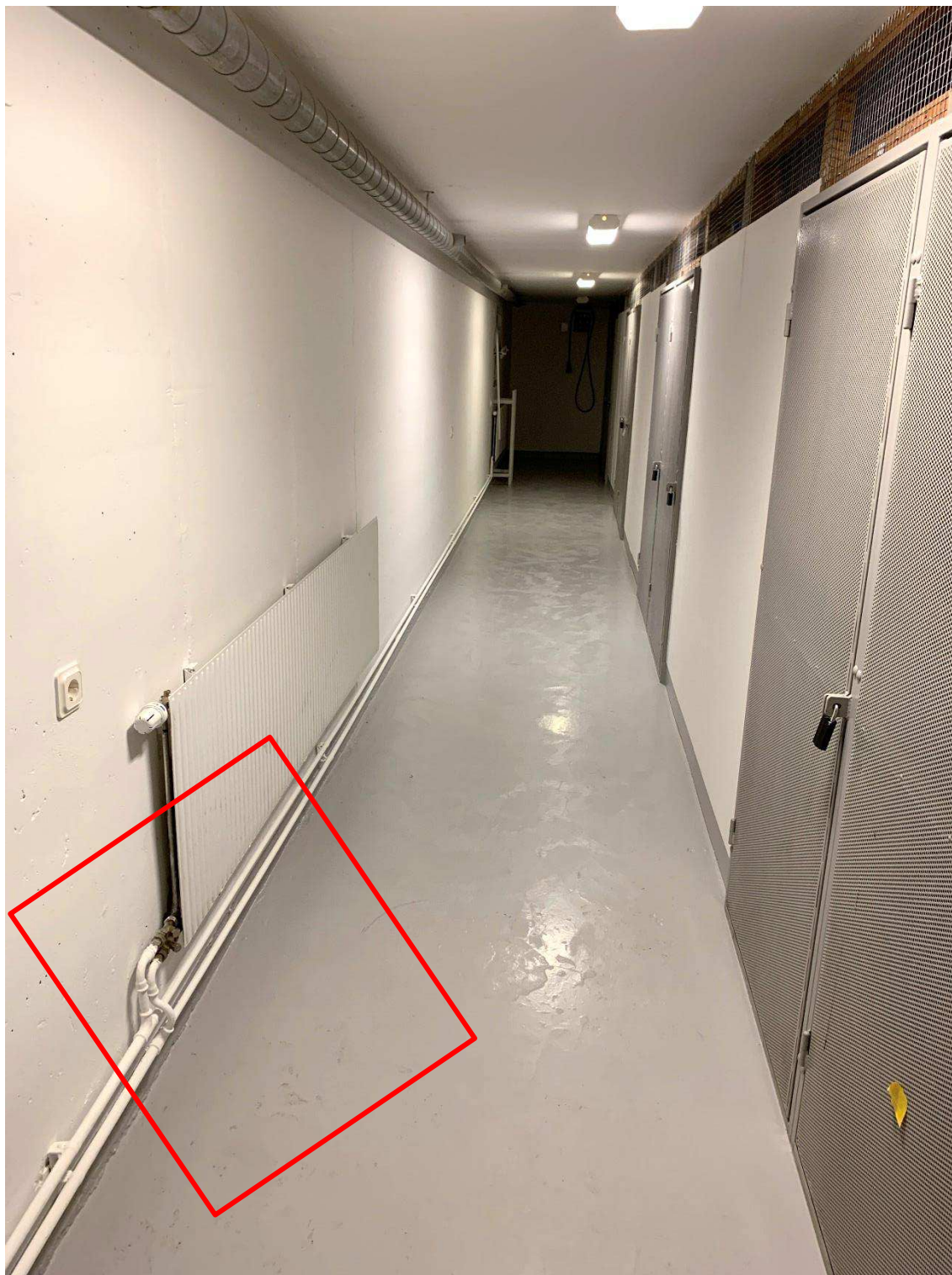
Figur 2. Översiktsbild över förrådskorridoren på Puddelugnsgratan 27-31.
