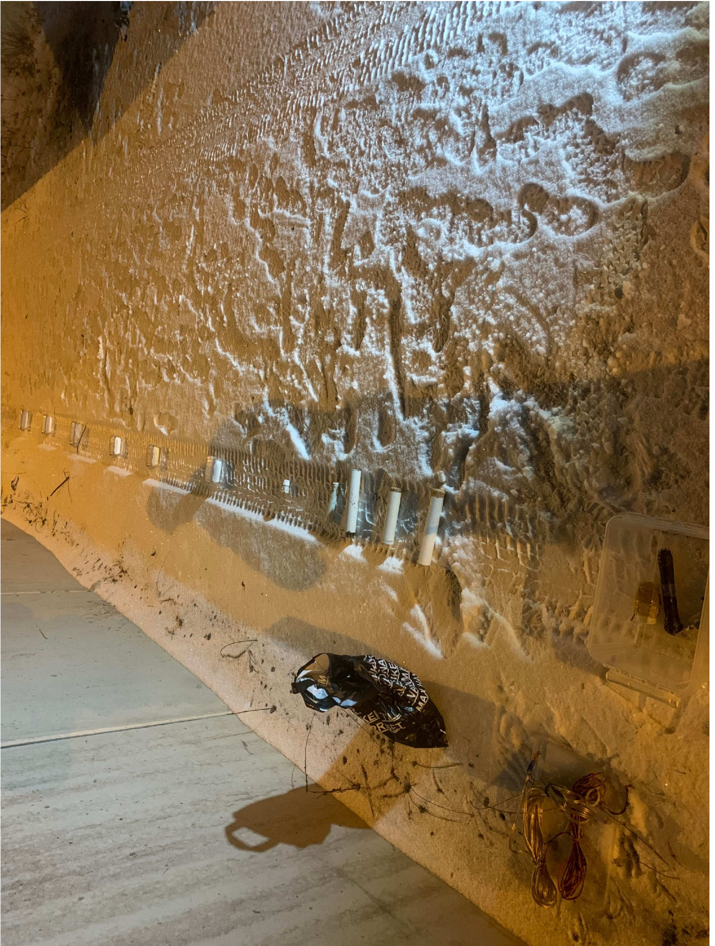
9. Översiktsbild på samtliga kärl innehållandes förmodade sprängämnen/anordningar.
