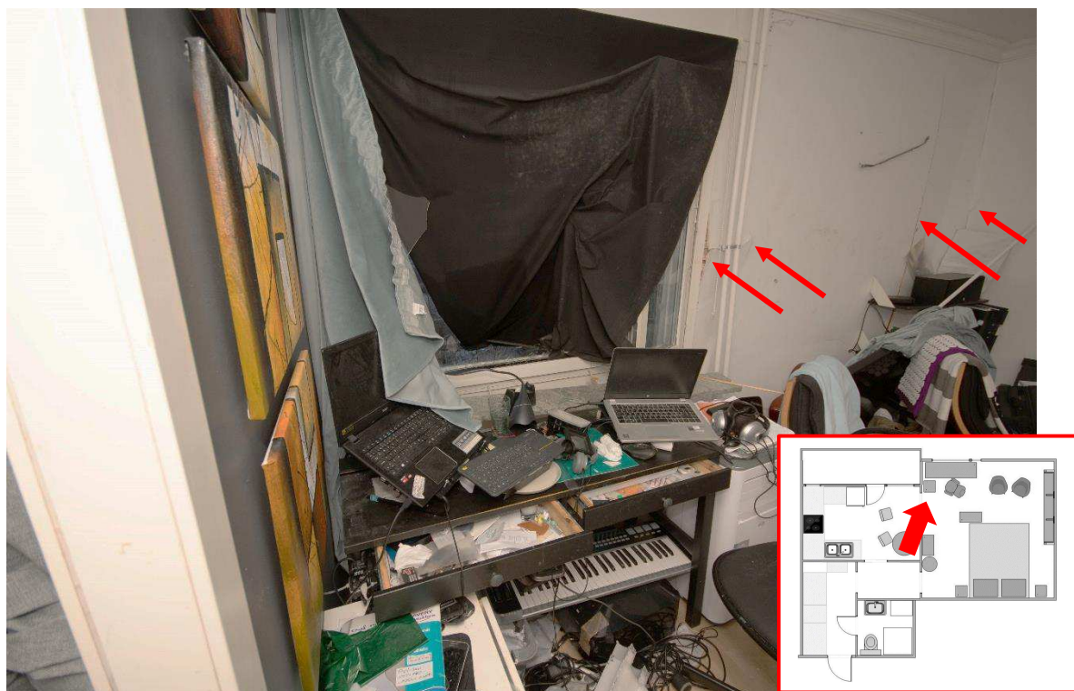
Figur 39. Datorbordet framför det krossade fönstret i sovrummet. De röda pilarna markerar skador i väggen.
