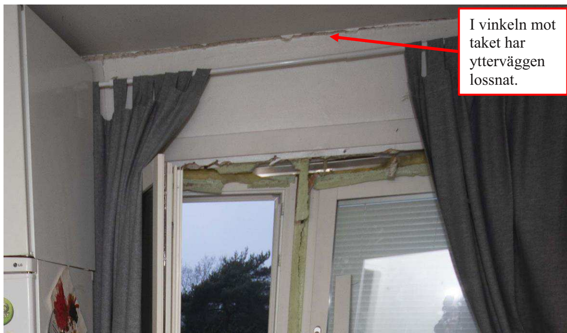
Figur 23. Närbild på skadorna i ytterväggen vid balkongdörren och fönstret.
