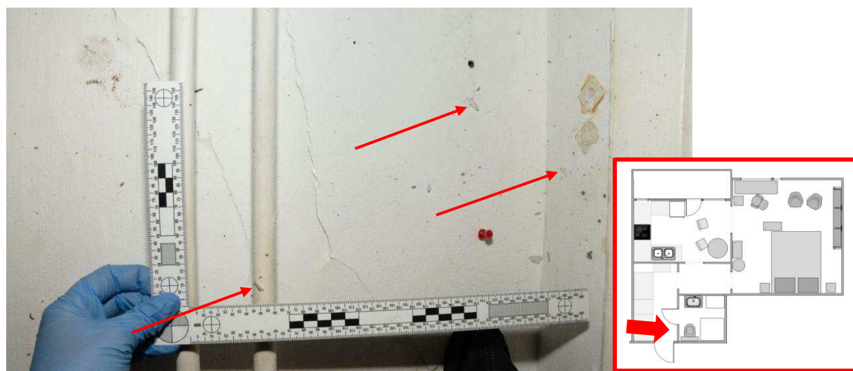
Figur 15. De tre röda pilarna visar några av de små plastfragment som satt fast på väggen mellan badrummet och ytterdörren. På bilden kan även blodstänk och sprickor i väggen iakttas.
