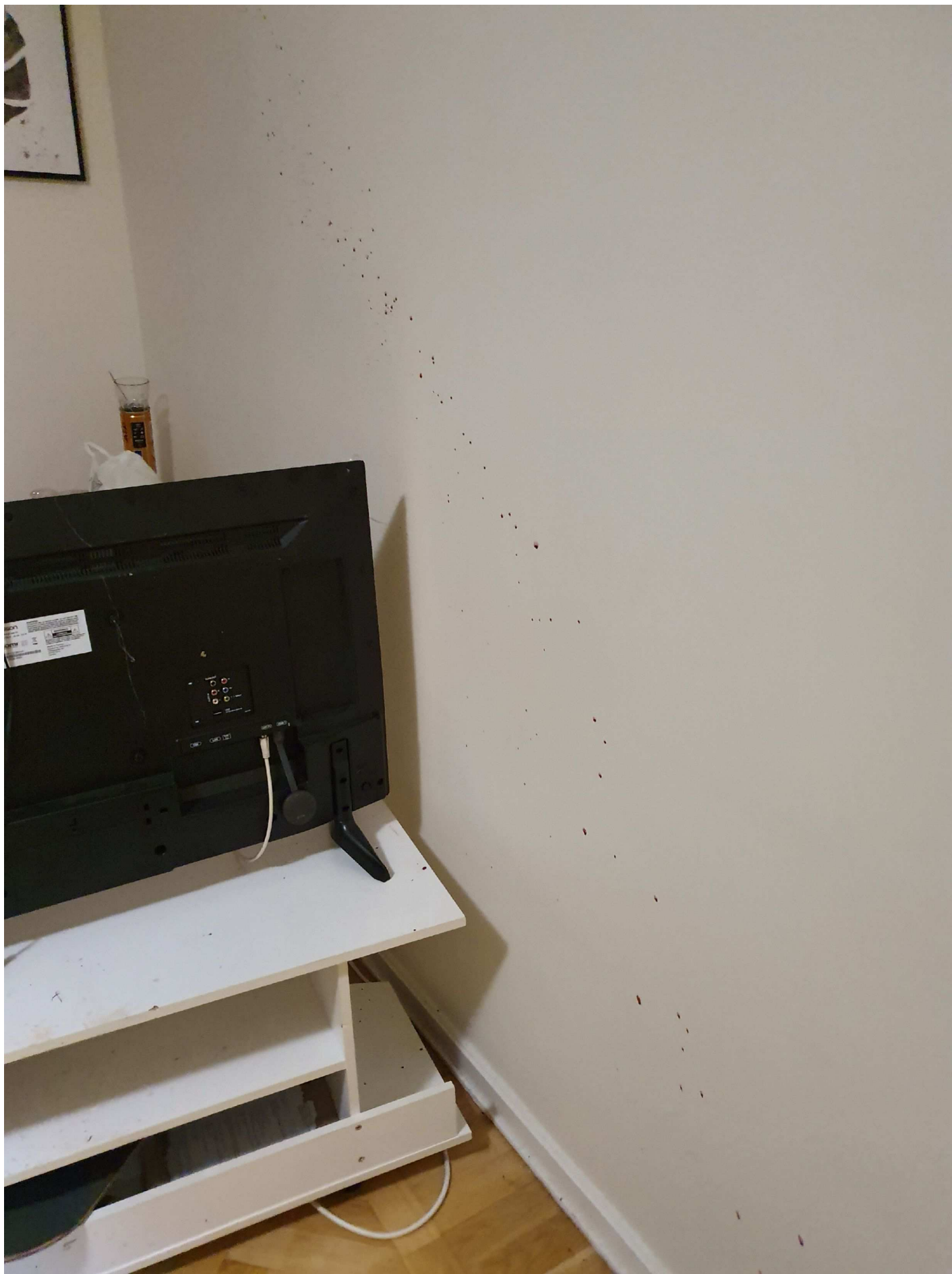
25. Lägenheten Snevringevägen 49b
