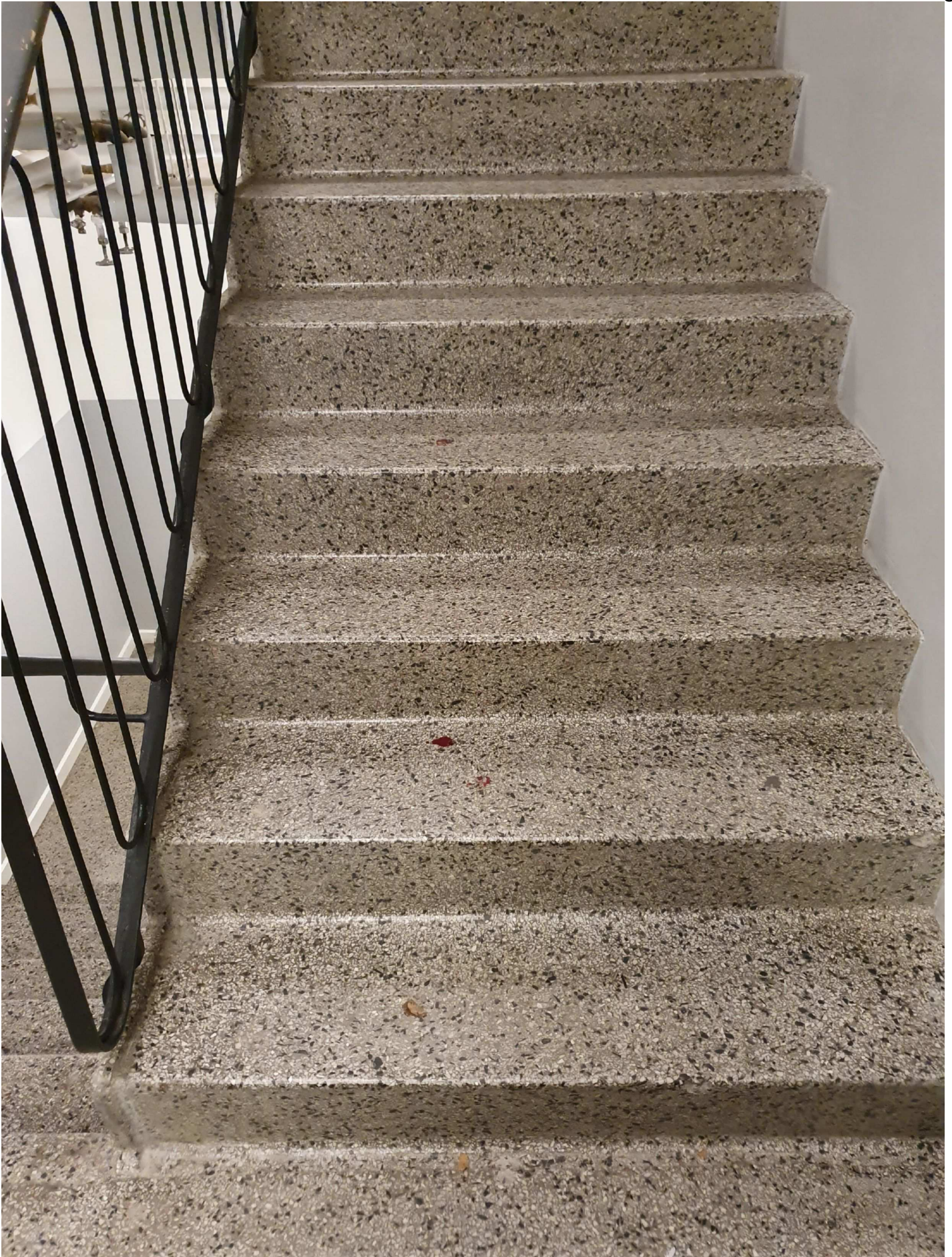
1. Trapphus Snevingevägen 49b
