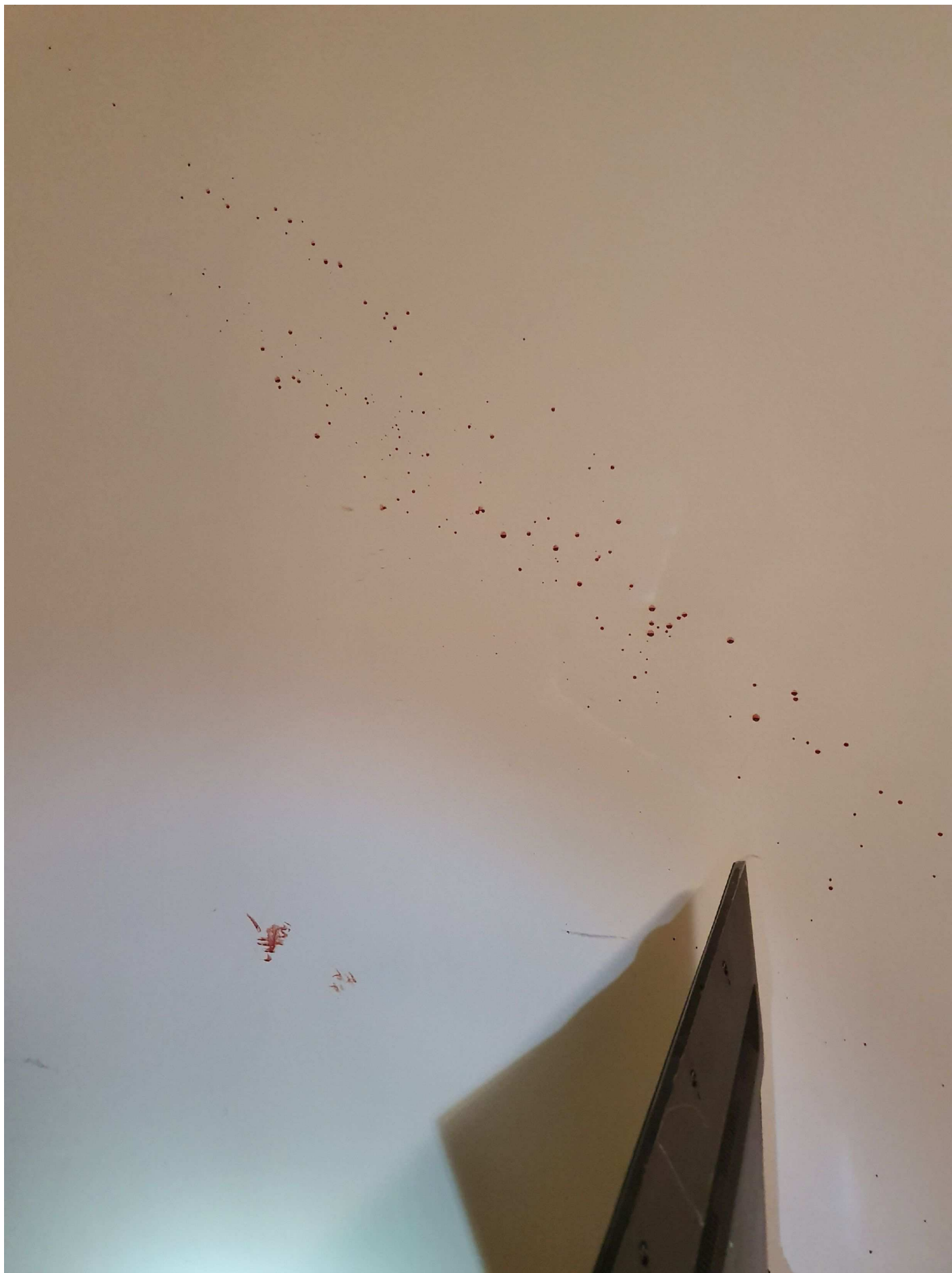
26. Lägenheten Snevringevägen 49b
