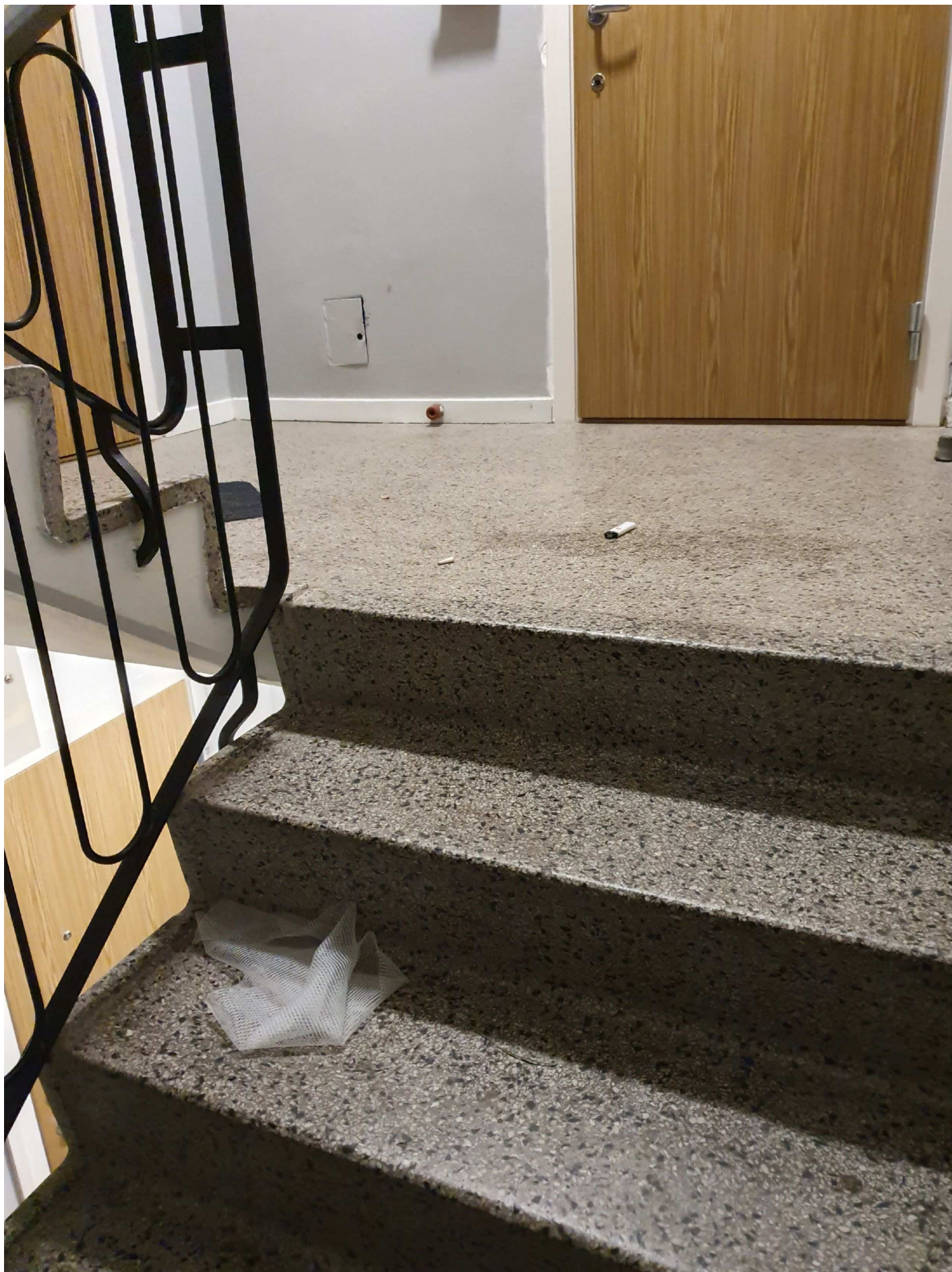
3. Trapphus Snevringevägen 49b
