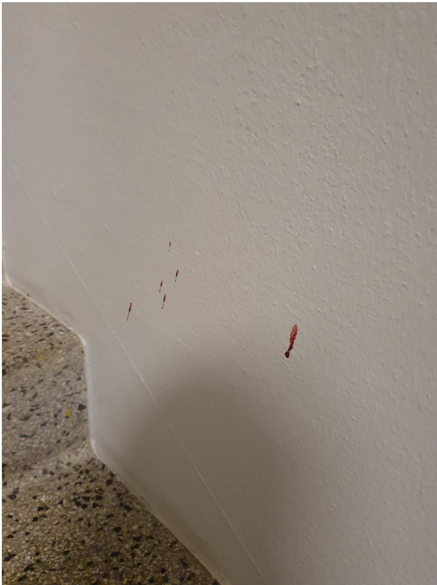
9. Lägenheten Snevringevägen 49b
