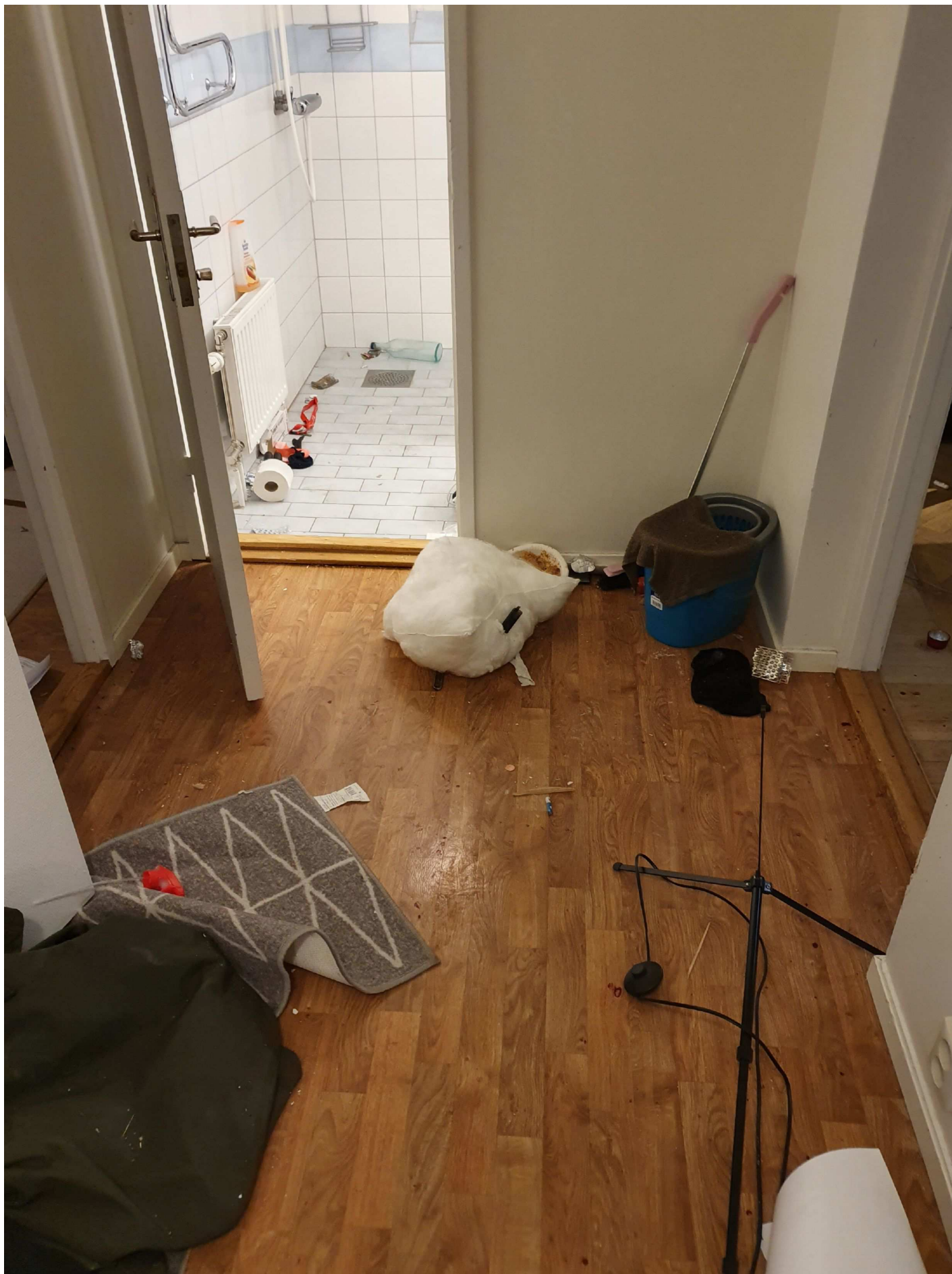
14. Lägenheten Snevringevägen 49b
