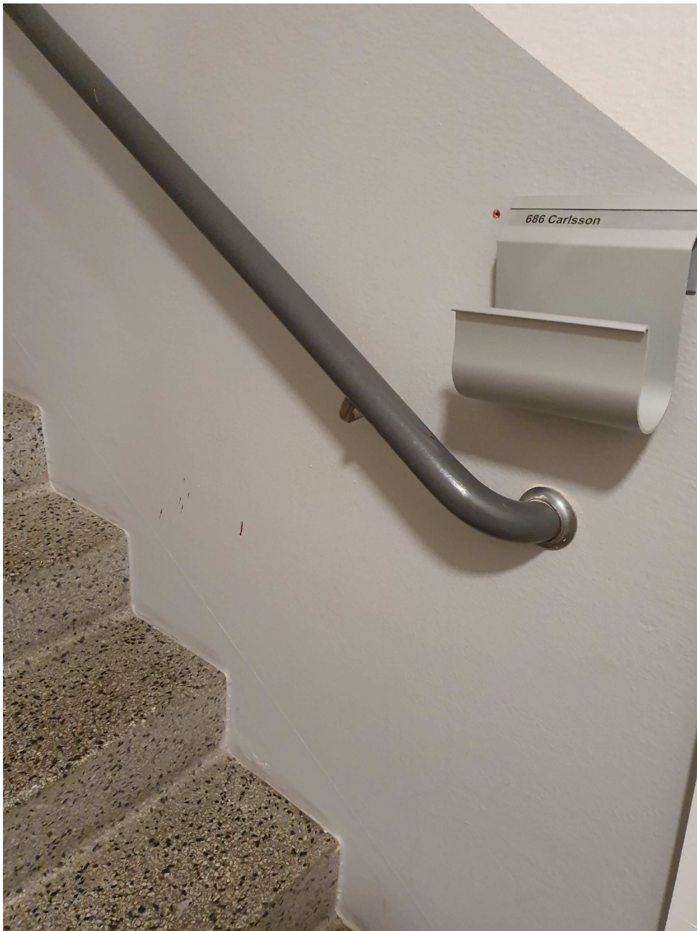
8. Lägenheten Snevringevägen 49b
