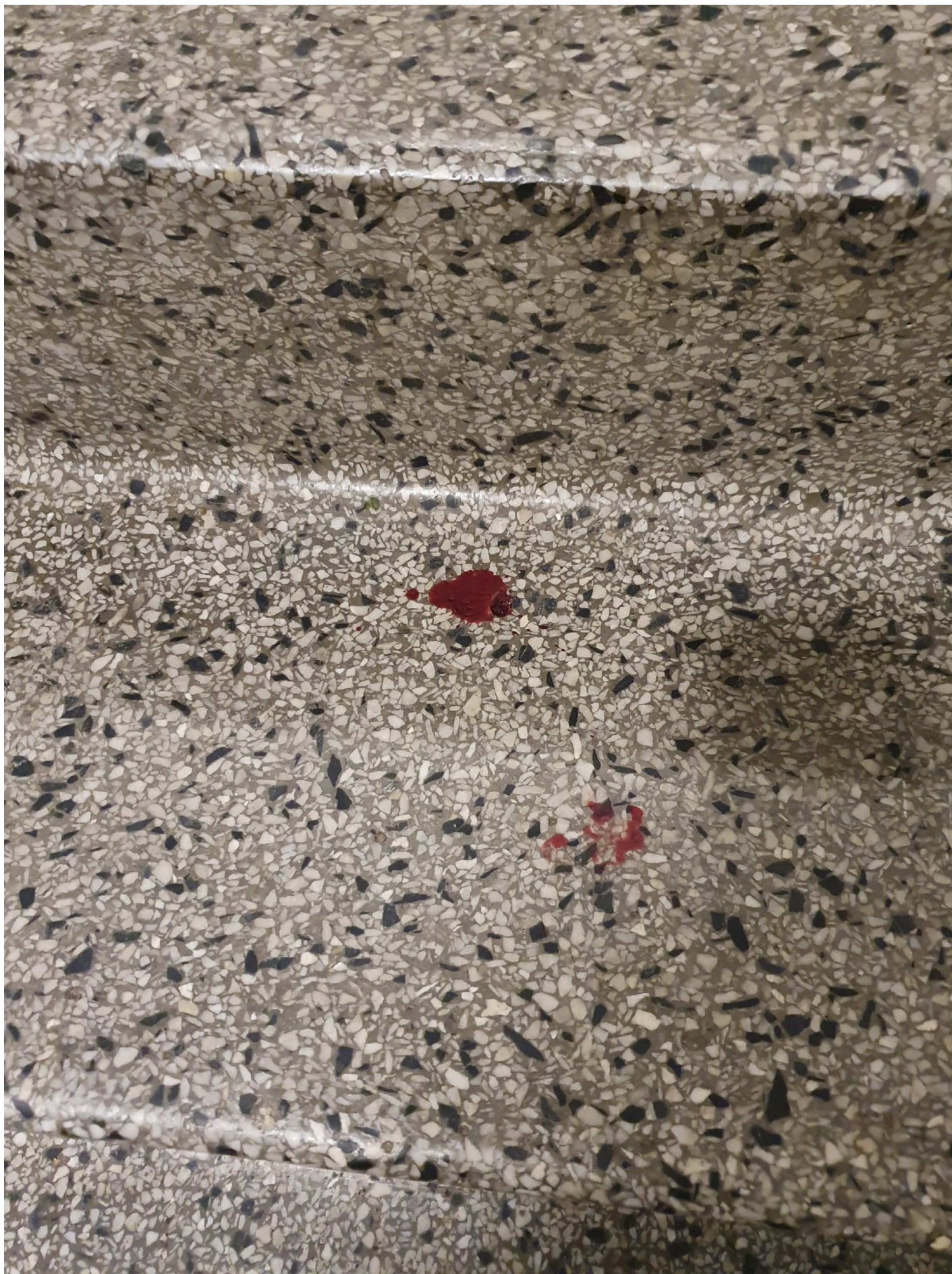
2. Trapphus Snevringevägen 49b
