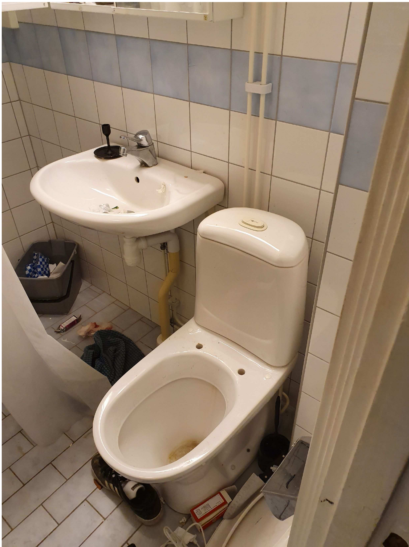
20. Lägenheten Snevringevägen 49b
