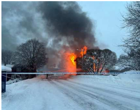
Byggnaden var bortom räddning.
