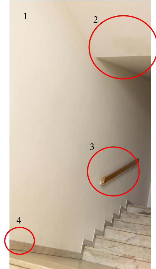
Figur 6. Referensbild från trapphuset Smedjegatan 3.
