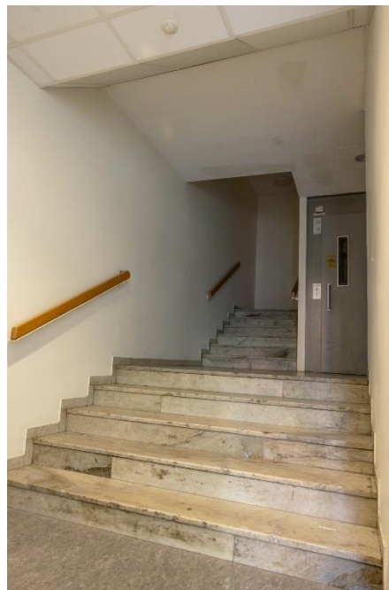
Figur 2 Översiktsbild inne i trapphuset.
