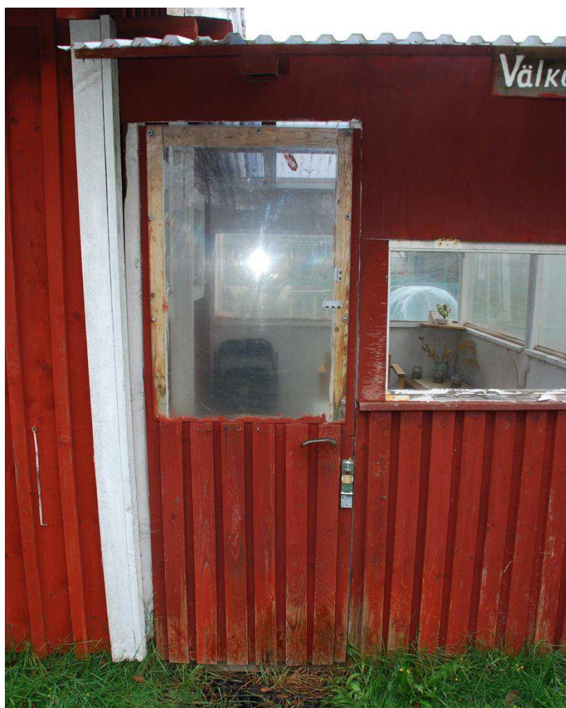
Bild 3. Dörr till altan.
