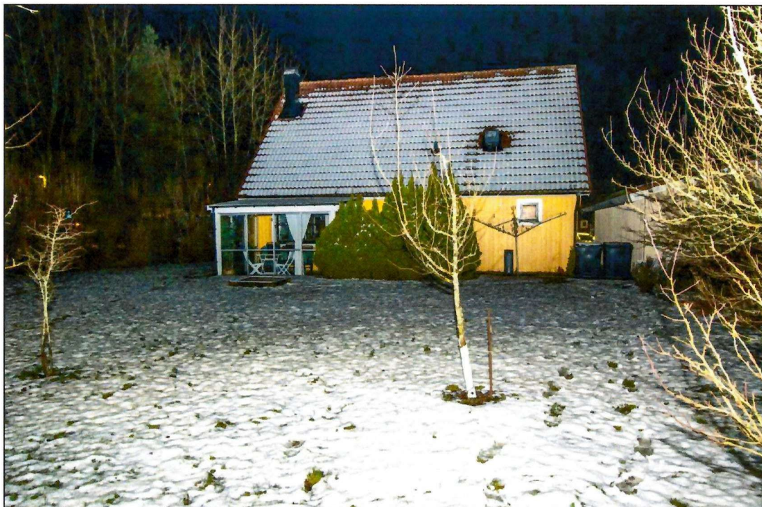
Bild 5 Husets baksida med uterum. Avsatta skosspår till höger i bild är avsatta i samband med undersökningen.
