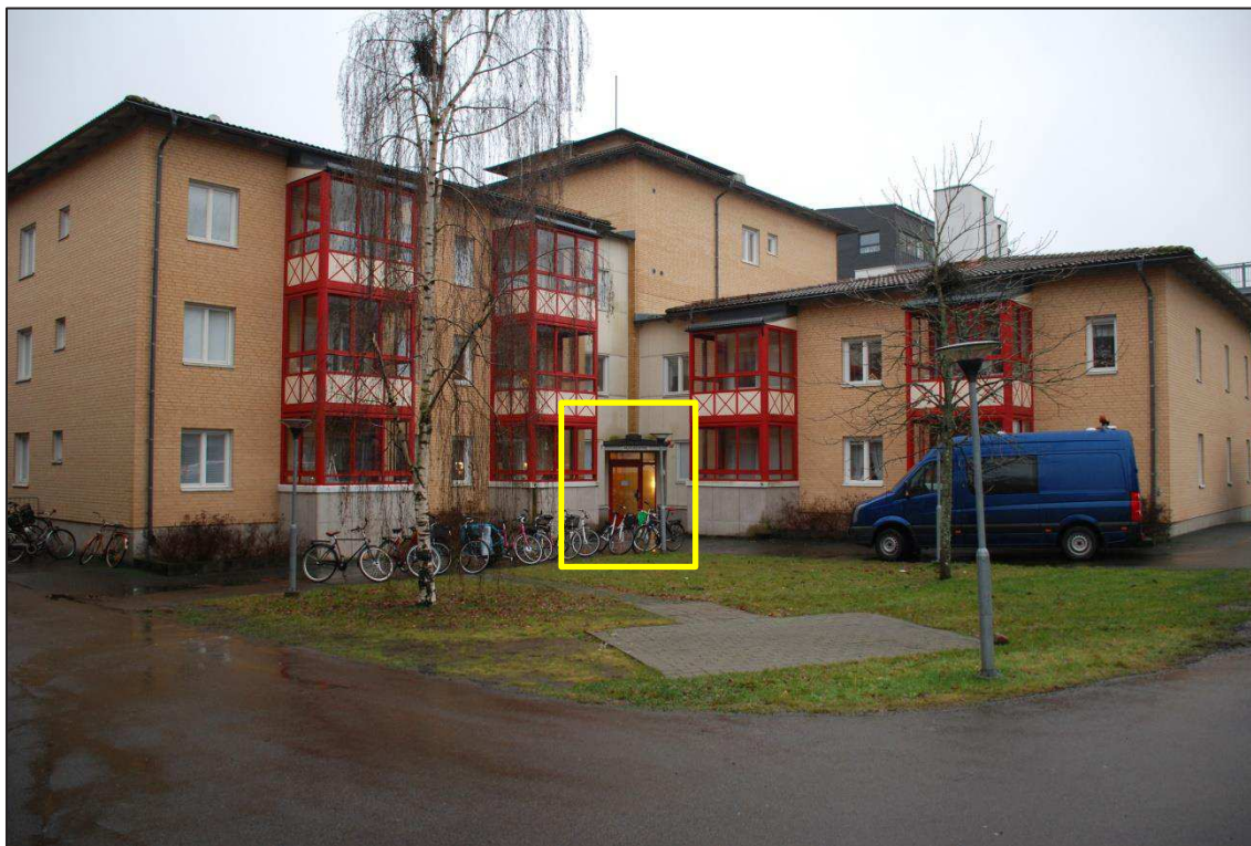
Figur 3. Entrédörren på baksidan av fastigheten markerad med rektangel.
