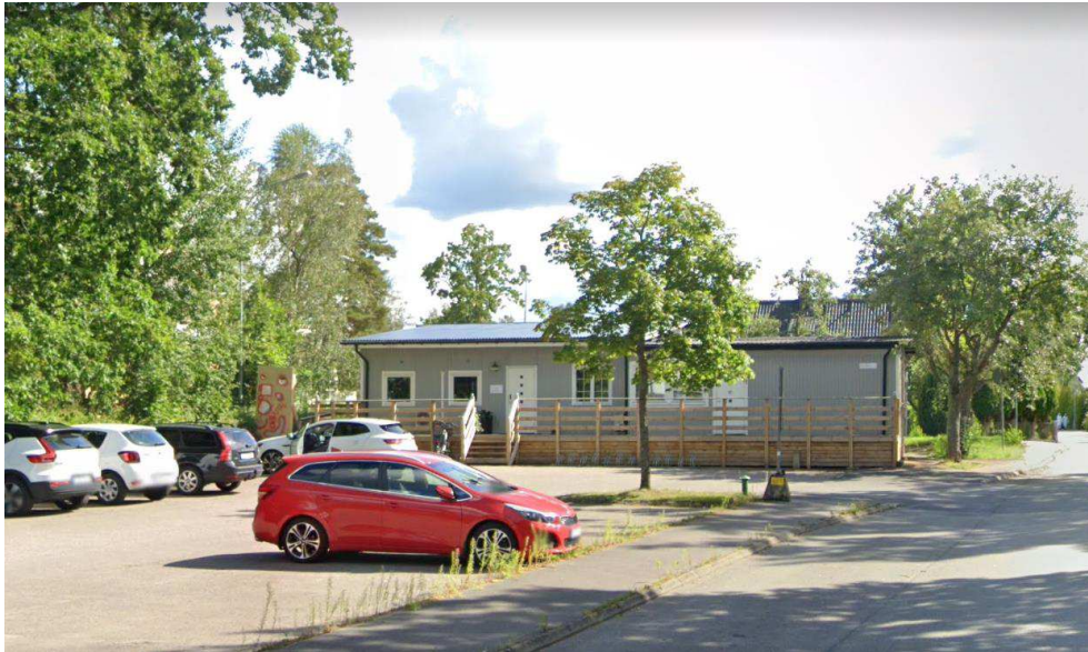
Bild 1. Foto för att visa den aktuella administrativa byggnaden/brandplatsen på Hagadalsvägen 54A i Växjö. Google maps.
