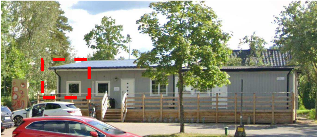
Bild 19. Adm-byggnaden åter sedd framifrån. Google maps. Notera del av husfasad markerad med röd streckad kvadrat, att jämföra med.....
