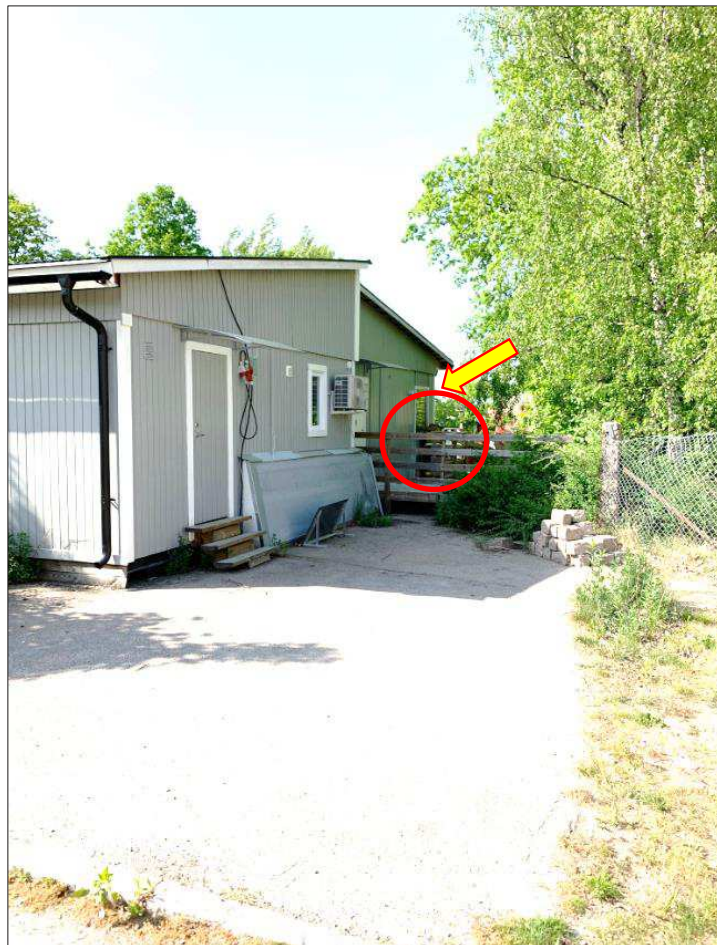
Bild 14. Adm byggnaden sedd från baksidan. Brandplatsen markerad med röd cirkel och samma husknut som markerades på bild 13 markerad likadant här. Fotot taget 2023-05-27 klockan 16:07:09 av polis Adam Ericson.
