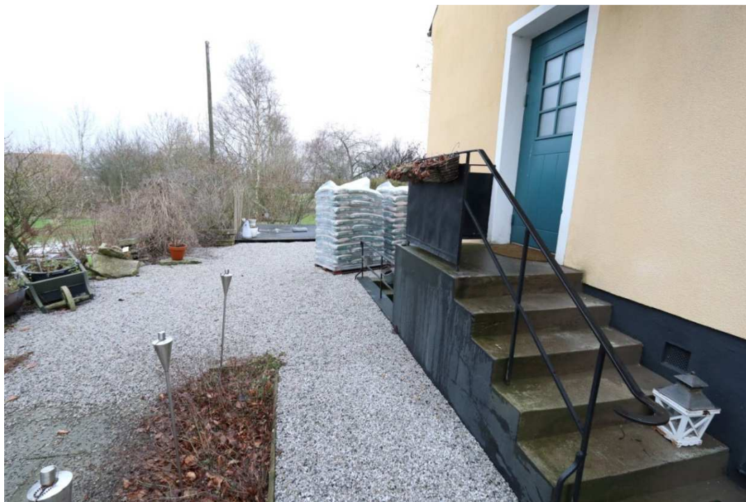
Figur 20. Entrén till bostaden. Bortom trappan till entrén skymtas trappan ner till källaren.
